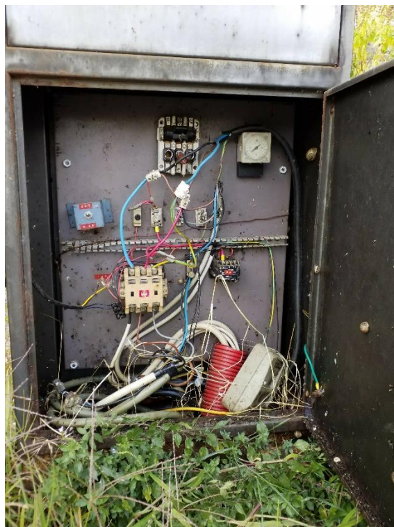
Quadri elettrici da sostituire
