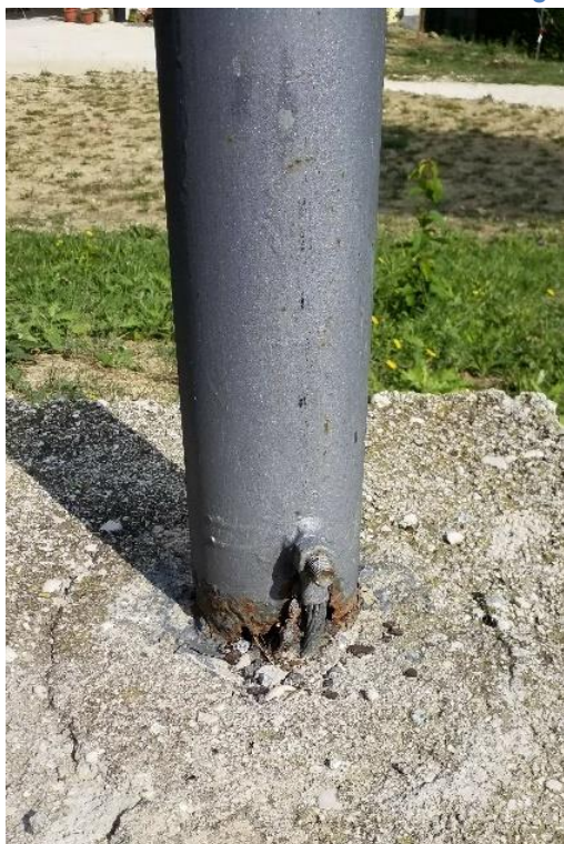
Sostegno corroso alla base
