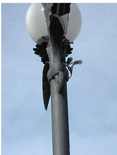
Connessioni non a norma esterne ai sostegni della Villa Comunale
