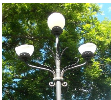
Apparecchi a globo su pali di arredo in cattivo stato di manutenzione
