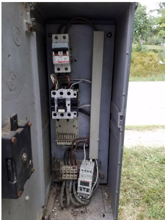
Quadri elettrici da sostituire
