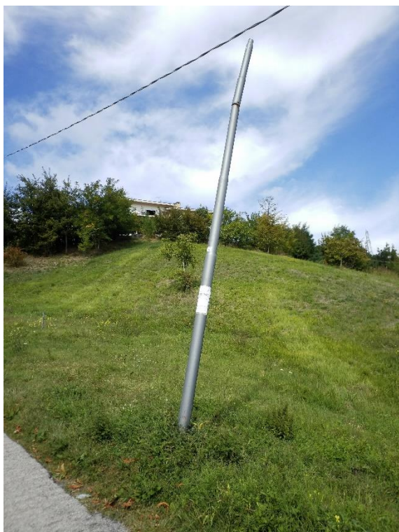
Sostegni corrosi e spezzati
