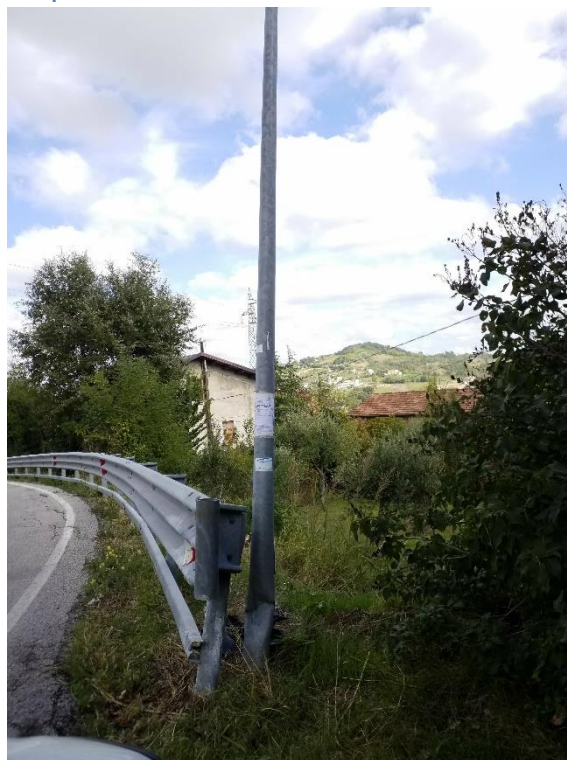
Sostegno incidentato
